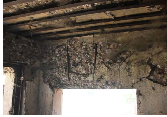
15. İç nedenlere bağlı bozulmalar, uygun olmayan malzeme kullanımı ve işçilik
