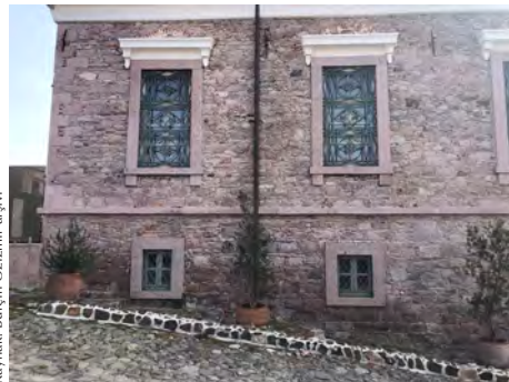
14 . Ana girişe ulaşılan kuzeybatı cephe: eğimli topoğrafya, sarımsak taşı duvar dokusu
