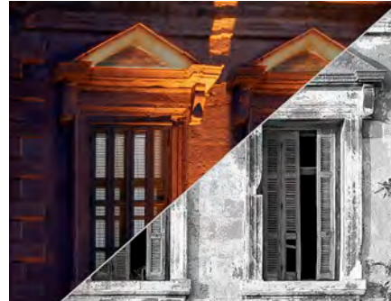
12. Özgün mimari elemanlar, bakımları ve temizlikleri yapıldıktan sonra sağlamlaştırma yapılarak iyileştirilmiş.
