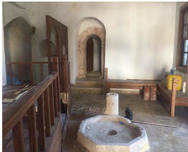
20. Soyunmalık mekânı restorasyonu sonrası
