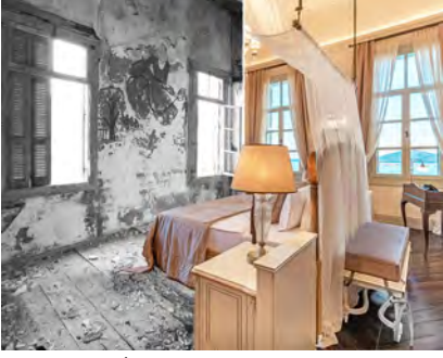
9. Yer in ruhu: İyi durumdaki özgün duvar dokusu sıvasız bırakılarak iç mekânda da sergilenmiş.
