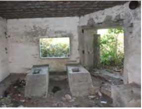
11. Çakmak Hattı iç mekânları
