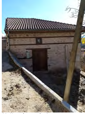
23. Kuzeybatı cephesi-restorasyon sonrası
