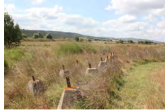
13. Çakmak Hattı'ndaki betonarme bariyerler
